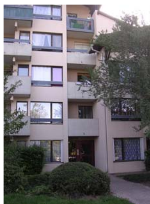
Travaux d'économie d'énergie
